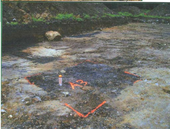
Figure 10 : Exemple d'un ancien puits de mine remblayé détecté après décapage
