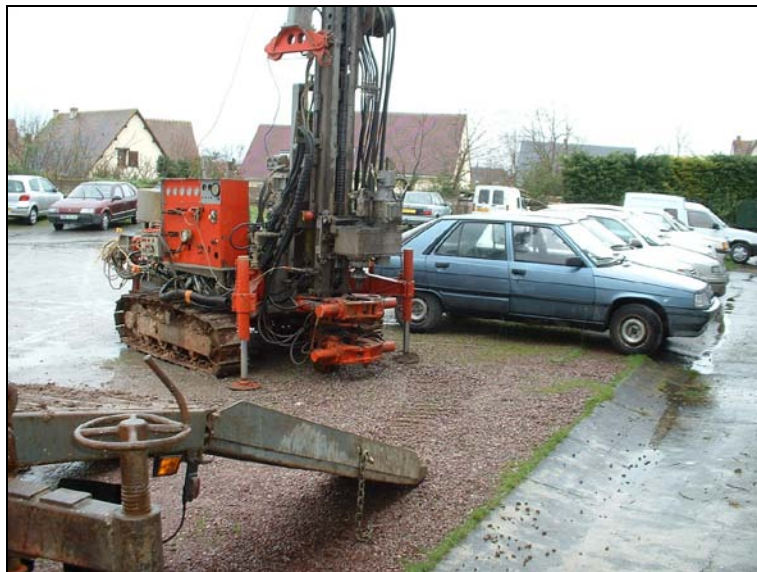
Figure 3 : Exemple de sondeuse pour une campagne de reconnaissance
