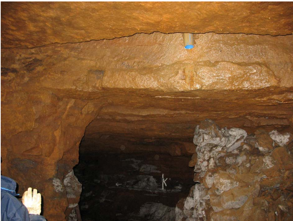
Figure 5 : Sortie d'un tubage au toit d'une cavité et dédié à une auscultation
