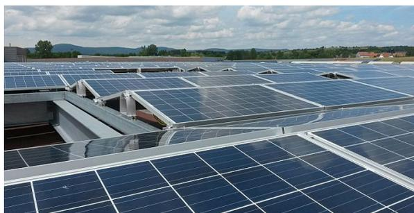
Centrale photovoltaïque en toiture de 186 kWc destinée à l'autoconsommation d'un bâtiment de Tryba Industrie à Gundershoffen (Bas-Rhin). Elle occupe une surface de toiture de 270 916 m<sup>2</sup>. Le taux d'autoconsommation des 174 000 kWh d'électricité produite par an a été estimé à 95% (source : lechodusolaire.fr).
