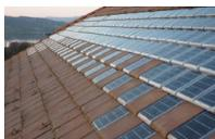
Toiture composée de tuiles photovoltaïques (luxol.fr)
