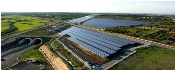
Parc photovoltaïque de l'autoroute Catane-Syracuse en Sicile d'une puissance totale de 13,2 MG raccordé au réseau moyenne tension (source : pizzarotti.it)
