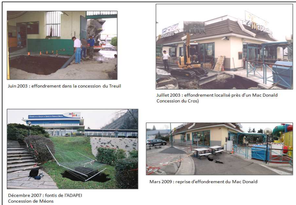
Figure 28 : Exemples d'effondrements localisés récents dans le bassin stéphanois
