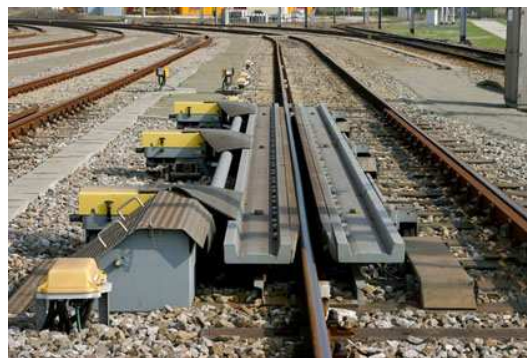
Figure 14 : Rail freineur (gare d'Antwerpen), source : SNCF Réseau
