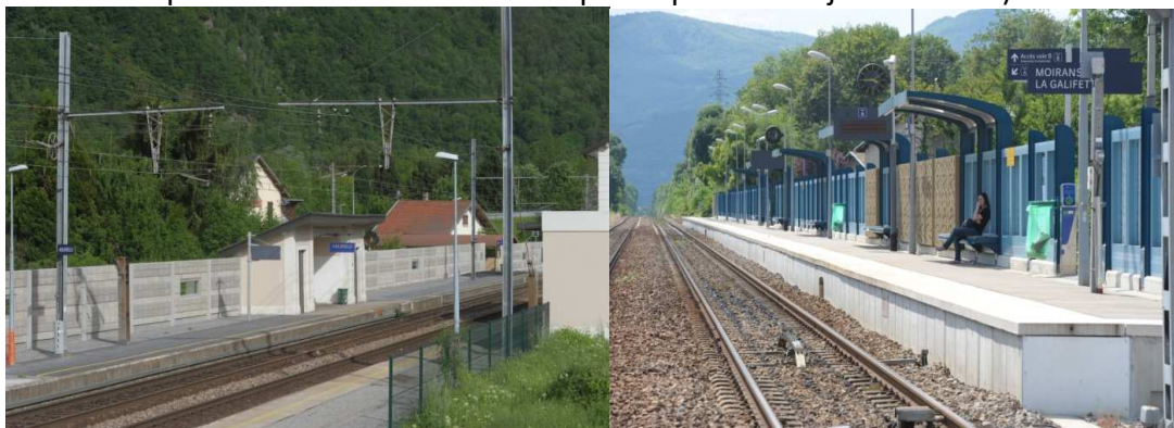
Figure 13 : Exemples d'écrans acoustiques à Aiguebelle et Moirans, source : SNCF Réseau
