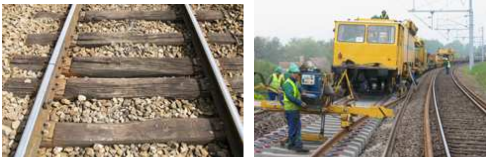
Figure 9 : Rails courts sur traverses bois et longs rails soudés sur travers béton, source : SNCF Réseau
