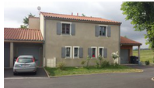
Vue sur les logements mitoyens de l'Ophis. Vue sur les parking individuels.
