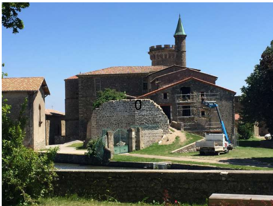
Réhabilitation d'un bâtiment en cœur de bourg à Pélussin (42)
