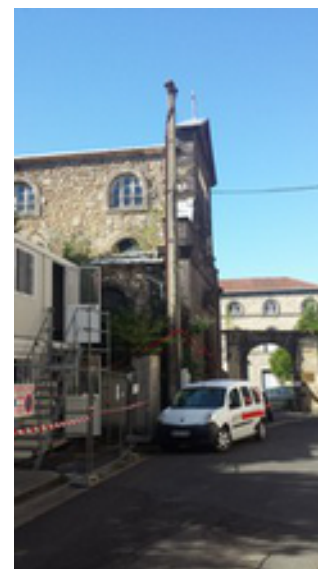
Source photo : DDT63
