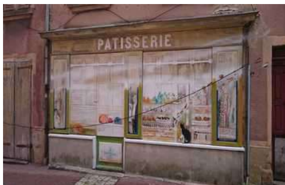
Façade commerciale peinte en centre-bourg, Saint-Julien-Molin-Molette (42) Source : CEREMA
