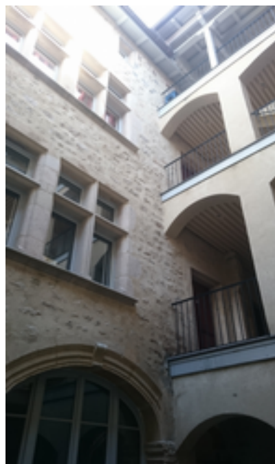
Cours intérieure de l'hôtel Vilnoz après rénovation. Source : CEREMA
