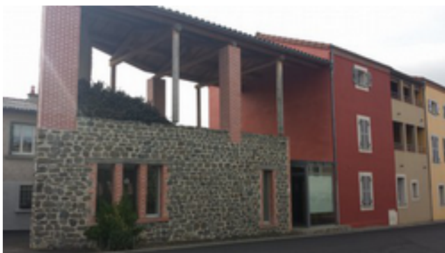
Vue sur la salle communale de la communauté de communes. Source DDT63
