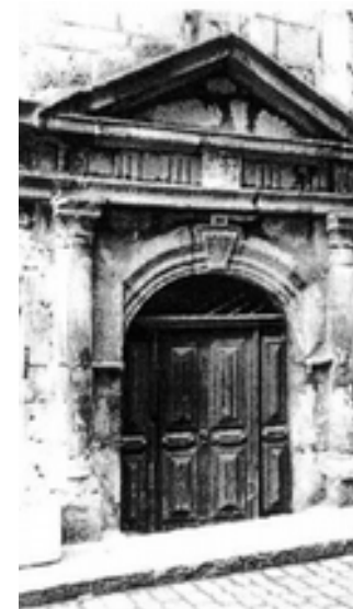
Photo extraite du dossier AVAP, entrée de l'hôtel Vilnoz avant rénovation.
