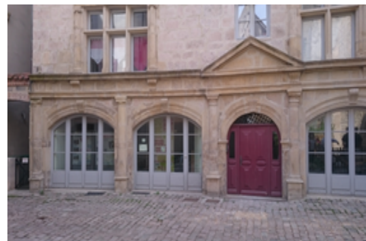
Entrée de l'hôtel Vilnoz après rénovation. Source : CEREMA
