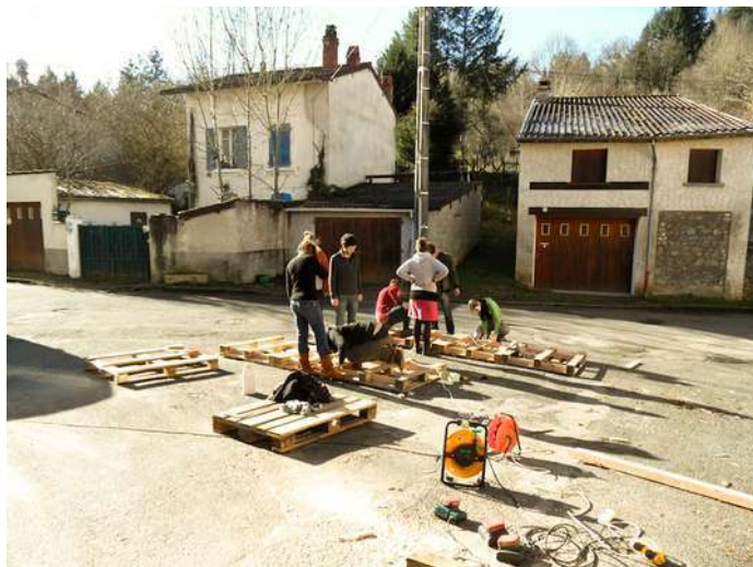
A Châteldon (63), le collectif etc. a mis en place des chantiers participatifs pour réinventer les espaces publics. (source collectif etc.)
