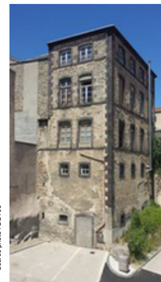
Source photo : DDT63
