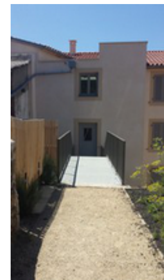
Source photo : DDT63
