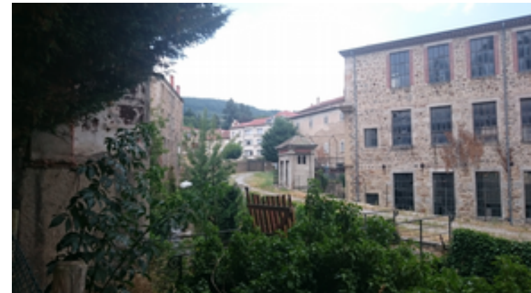
Les espaces pleins et vides se complètent, mêlant petit patrimoine, bâti dégardé, espaces végétalisés et voies de déplacement apaisées.
