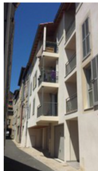
Source photo : DDT63
