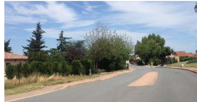
Plusieurs aménagements peuvent permettre de faire ralentir les véhicules : changer de décors, de revêtement, ou placer des obstacles. Ci-dessus à Maclas (42 -1580 hab.)
