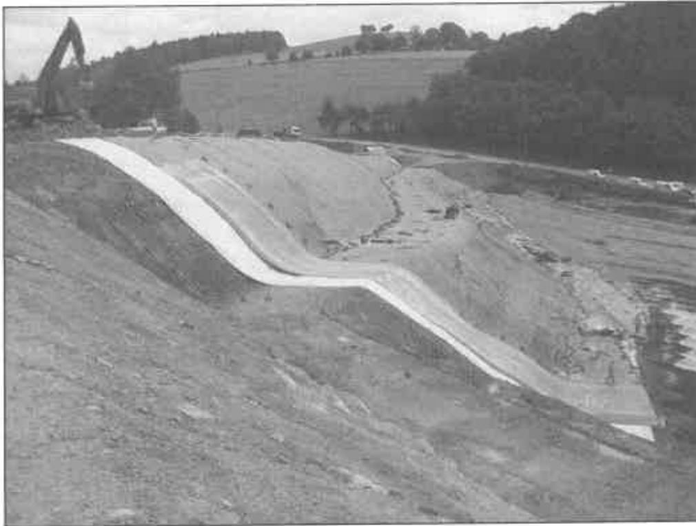
**Figure 4 : Vue sur un casier en cours de création (pose de la barrière active) (Source : SUEZ RV Borde Matin)**
