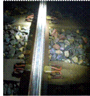
Rail après meulage
