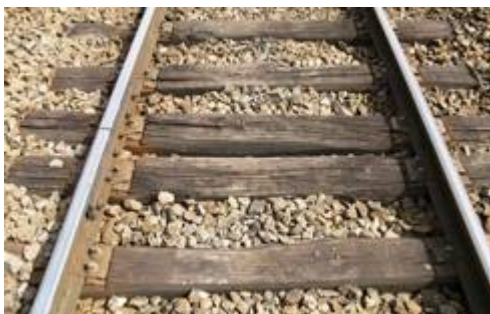
Rails courts sur traverses bois
